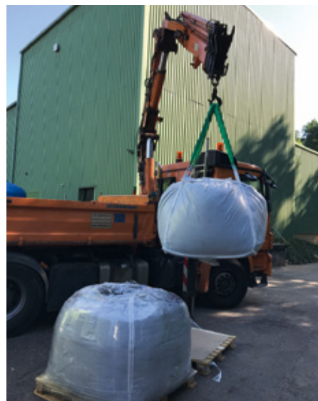
Bild 3 Ein Kran hebt die Big Bags mit Saratech Adsorbentien zum Befüllen des Filterbehälters
