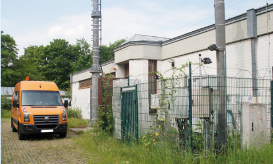
Bild 1 Im Pumpwerk „Angermund“ in Düsseldorf betreibt der Stadtentwässerungsbetrieb Düsseldorf zwei SE1.100.150.75 Ex Abwasserpumpen unter besonderen Bedingungen.
