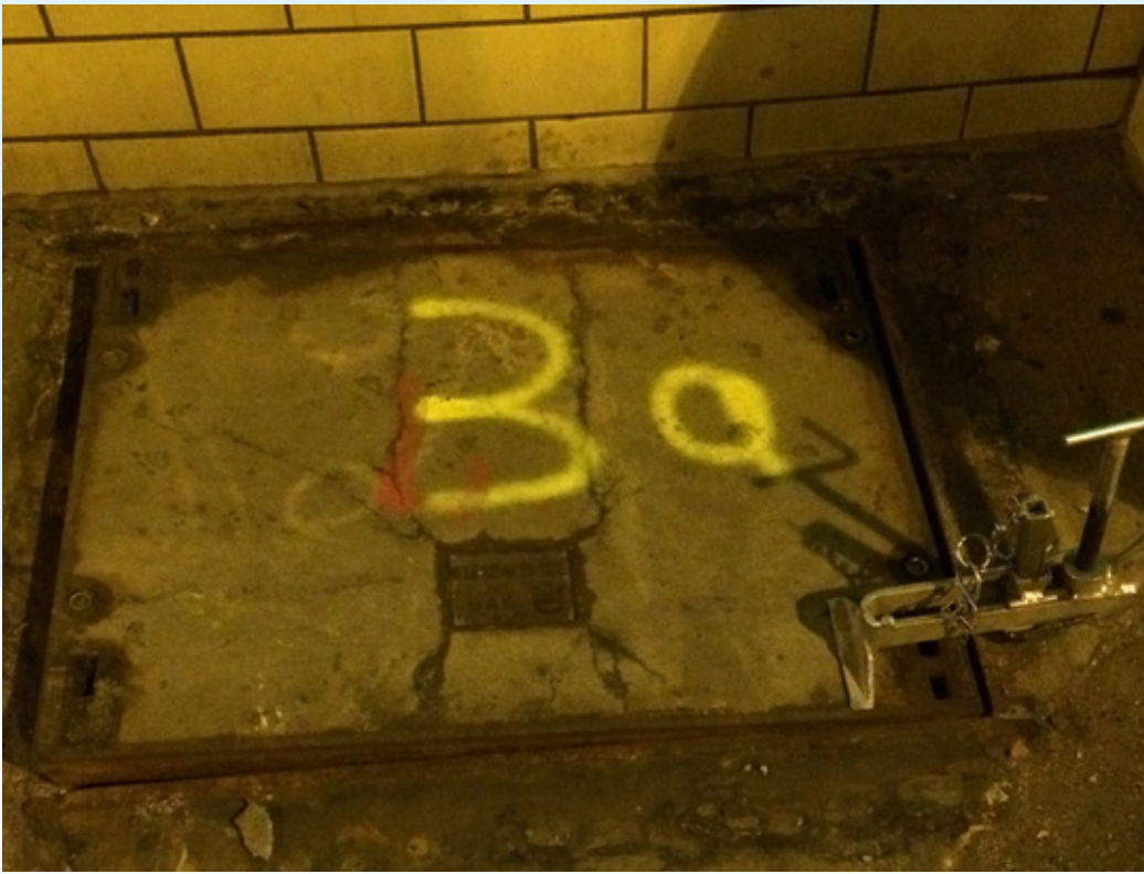
Bild 1 Sanierungsbedarf: Schachtabdeckungen können enormen Bedingungen wie einer erhöhten Korrosion ausgesetzt sein. Produkte aus Stahlbeton- oder Beton-Guss halten dieser nur bedingt stand.
