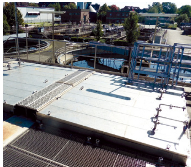
Bild 3 Dem Ozonreaktor schließt sich eine biologische Nachbehandlung an.
