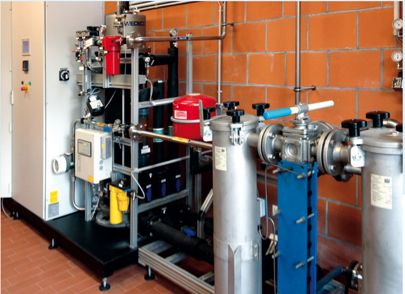
Bild 1 Das Wedeco-Ozonsystem
